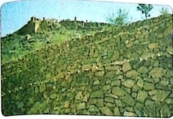
إنجاز متراس لحماية الاراضي المنحدرة من الانجرافات الكبرى.
