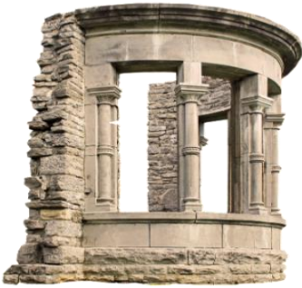
بناية قديمة متآكلة بفعل الأمطار الحمضية
