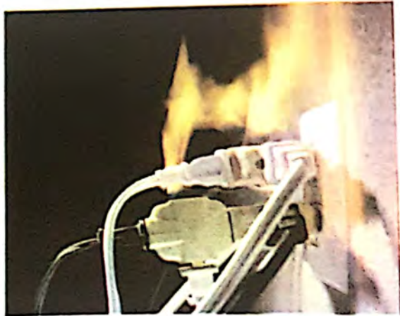
3 - استخدام غير سليم لمأخذ الكهرباء في المنزل!
