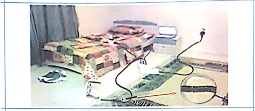
الوثيقة ① : أجهزة كهربائية عديدة تشتغل بالكهرباء في نفس الغرفة!
