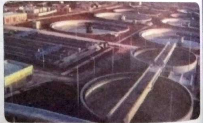
محطة تنقية مياه الصرف الصحي (براقي - الجزائر)
