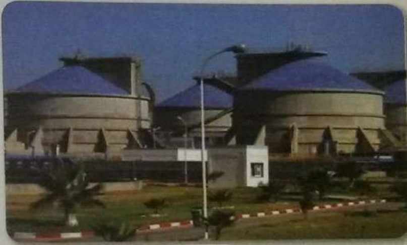
محطة تحلية مياه البحر بالمقطع، وهران
